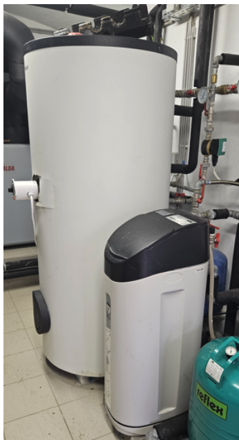
Slika 16: Zalogovnik tople sanitarne vode
